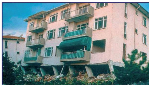
Bâtiment avec un rez-de-chaussée flexible (Izmit, Turquie, 1999)
